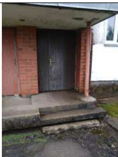
Kāpņu telpas ārdurvis
